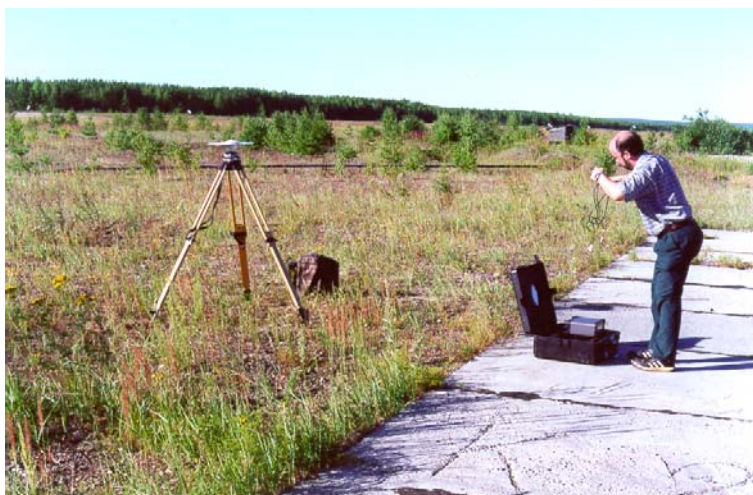
Рис. 67. Установка наземной базовой GPS станции Z-12 Ashtech для обеспечения воздушной лазерной съемки (работы выполняет профессор Е.М. Медведев).
